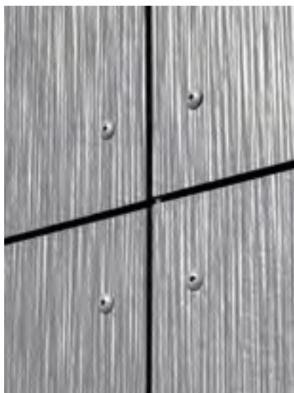
Hardie® Panel Schraubbefestigung
