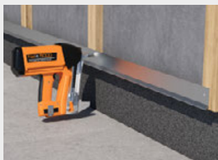
Befestigung des Sockel-Lüftungsprofil.
