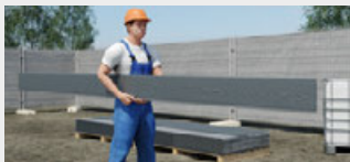
Produkte bei der Montage immer hochkant tragen.
