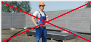
Hardie® VL Plank Fassadenplatten werden ineinander gesteckt geliefert. Paneele sind bei der Entnahme von der Palette seitlich herauszuziehen und erst dann anzuheben.
