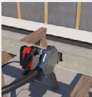
Benutzen Sie für den Zuschnitt ein für Faserzement geeignetes Sägeblatt (empfohlen: Hardie™ Blade)
