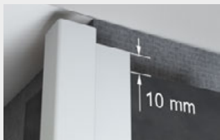
Hardie™ Plank MetalTrim™ Zierleisten oben und unten 10mm überstehen lassen.
